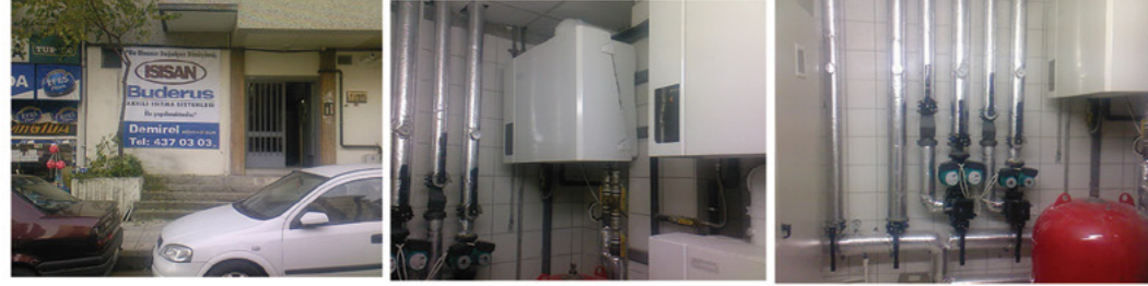
Tuna Apartmanı Merkezi Sistem Kaskad Uygulaması ve Doğalgaz Tesisatı
