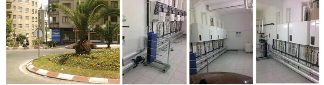
Nazar Apartmanı Merkezi Sistem Kaskad Uygulaması ve Doğalgaz Tesisatı
