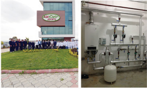
Adıyörem Çiğ Köfte Fabrikası Isıtma Tesisatı- Yangın Tesisatı
