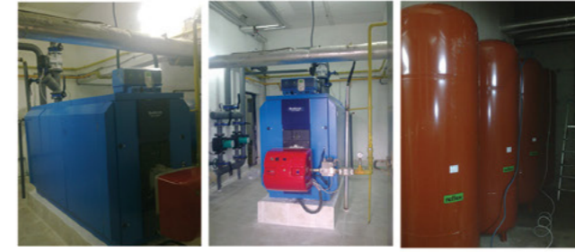
Pelit Köy S2 Blok Kazan Dairesi Dönüşümü ve Doğalgaz Tesisatı
