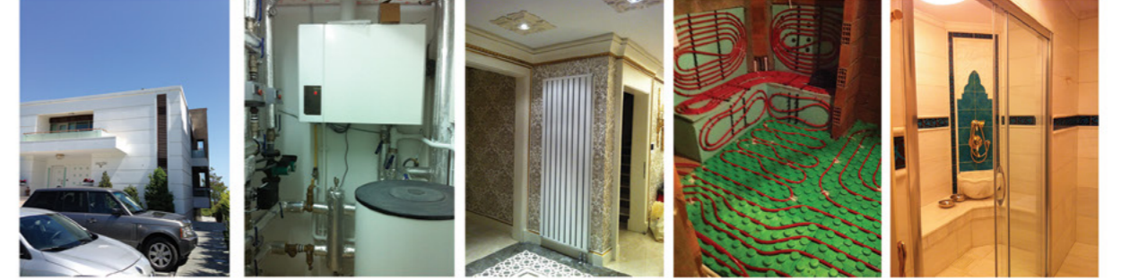
C.Yeşilyurt Villası Kalorifer Tesisatı, Pis Su - Temiz Su Tesisatı VRF Tesisatı, Doğalgaz Tesisatı
